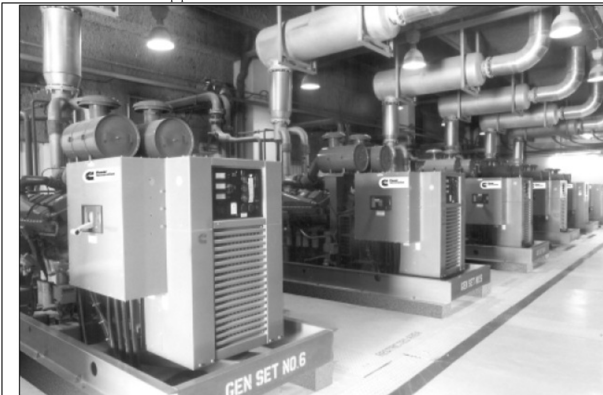
Девять генераторных агрегатов по 900 кВА работают параллельно с использованием системы управления РССР на фабрике по разливу напитков на Среднем Востоке
