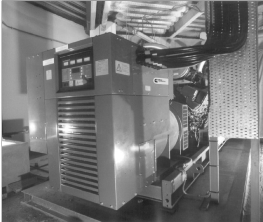
Подводка гибкого кабеля к модулю управления и кабельный канал для подводки сбоку.
