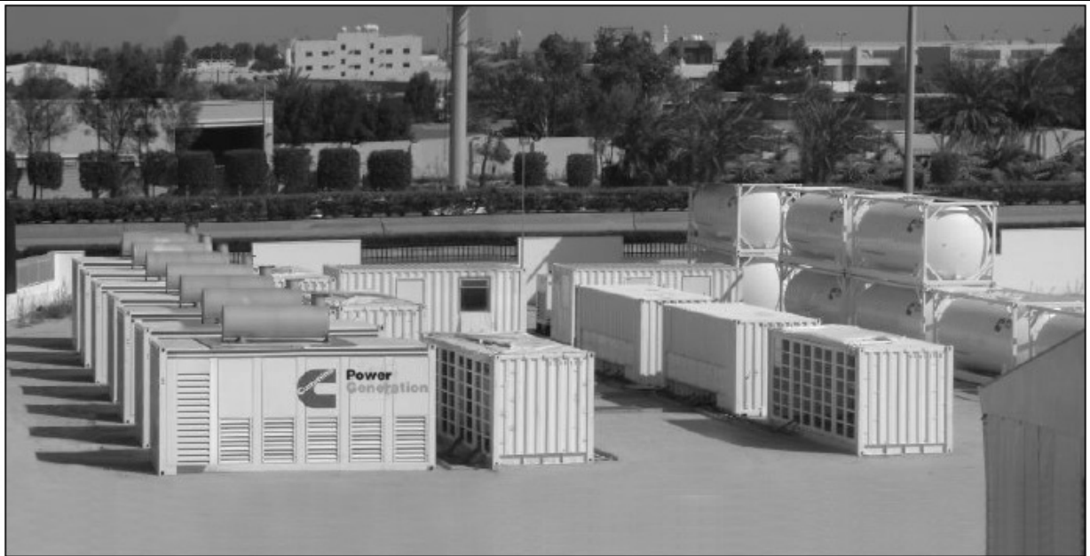
Пример электростанции на 5 МВт из 7 генераторных агрегатов по 1 МВт каждый. Обратите внимание на использование 20-футовых контейнеров для размещения трансформаторов, поста управления и распределительной аппаратуры. Справа штабелированы цистерны с топливом по 22000 литров каждая, установленные в специальные рамы.
