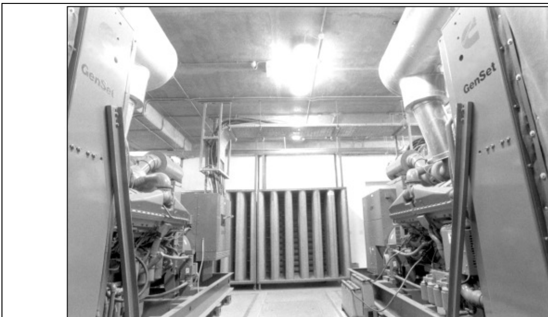
Аттенюаторы звука внутри машинного зала на два агрегата CP1250-5 по 1256 кВА каждый.
