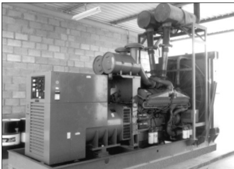
Модель 512 DFGB (640 кВА) в типовом варианте установке для жаркого климата
