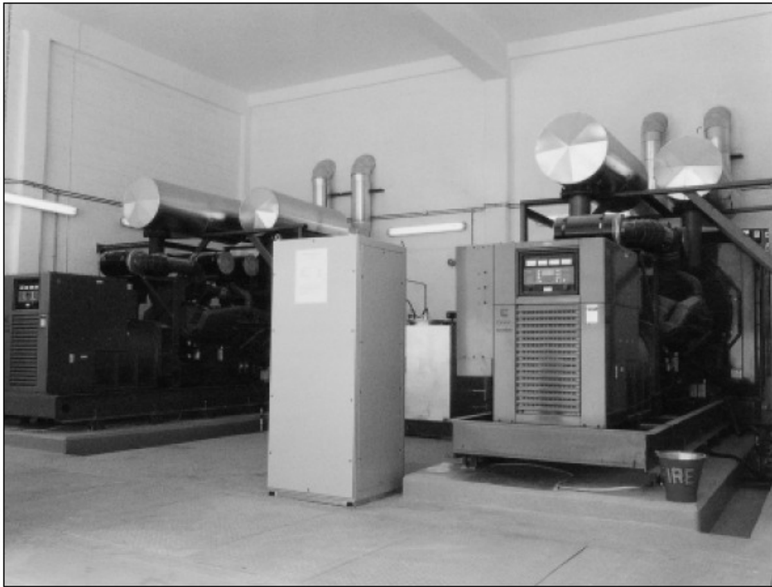
Генераторы, работающие независимо от внешнего источника питания и подключенные параллельно.
