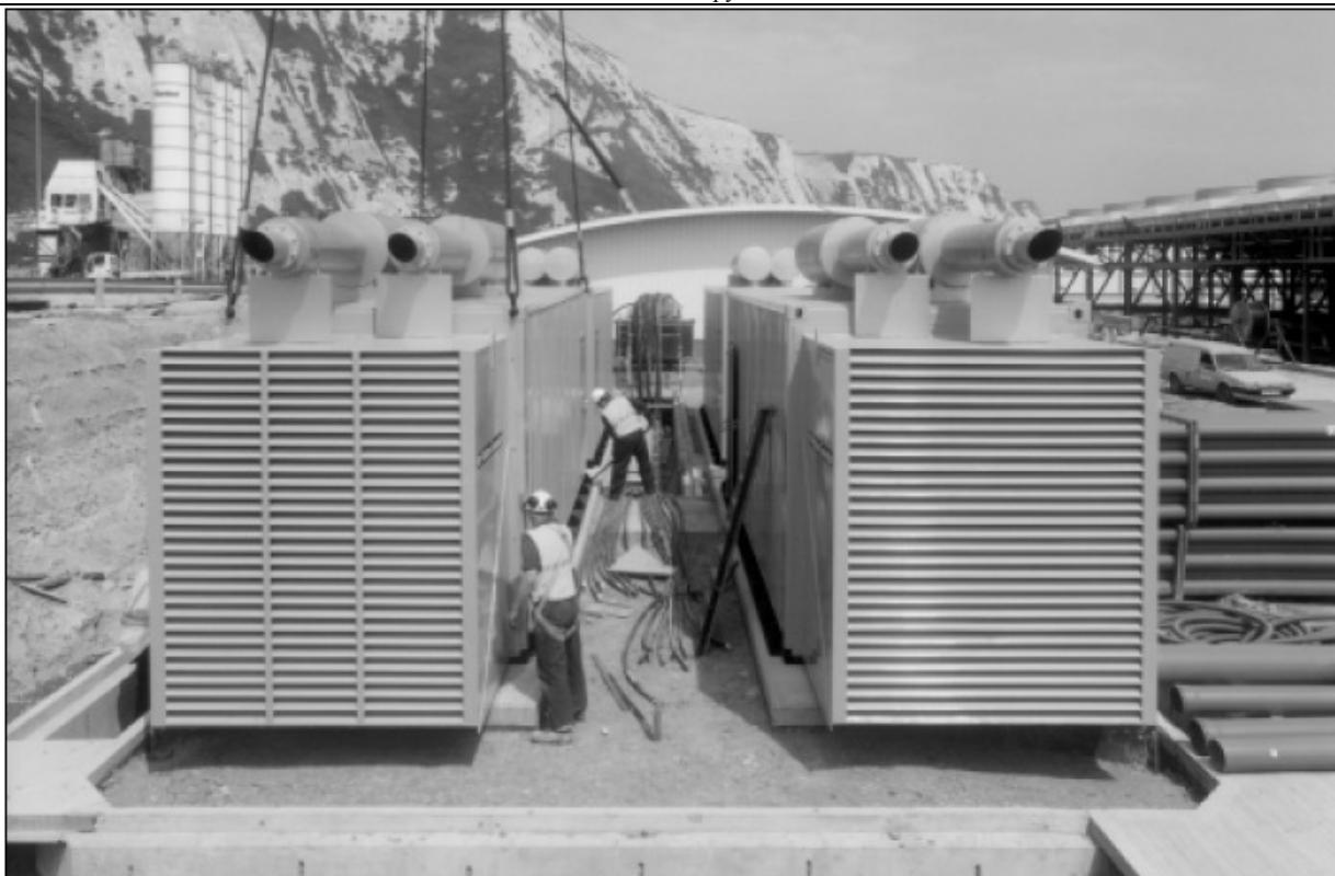
Четыре автоматически запускающиеся агрегата по 1250 кВА каждый с системой автосинхронизации в специально приспособленных контейнерах. Уровень шума снижен до 75 дБ(А) на расстоянии 1 метр. Фото предоставлено компанией Euro Tunnel -Transmanche
