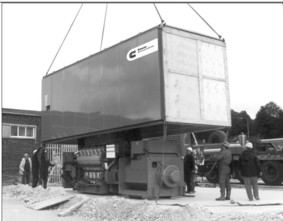
«Надеваемый» сверхмалошумный корпус для генератора первичного питания мощностью 3700 кВА устанавливается на специально подготовленное цементное основание.
