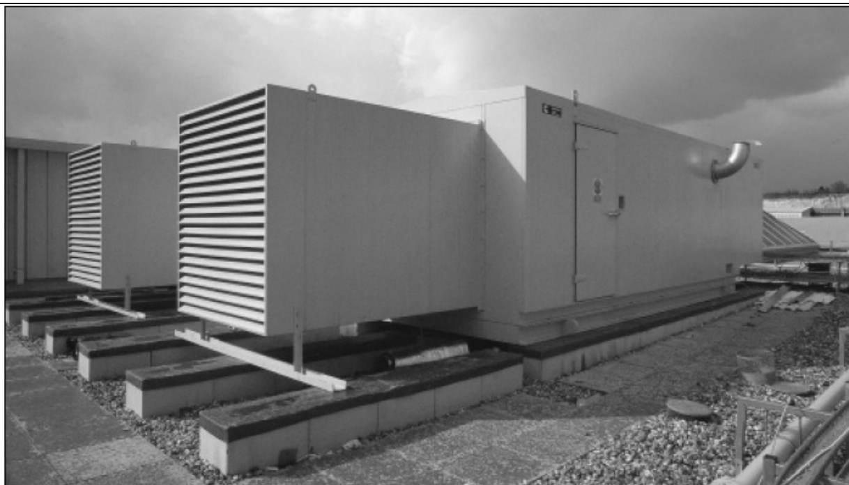
Два маломощных дежурных агрегата по 1000 кВА с «навесными» корпусами на крыше здания устраняют множество проблем, но создают другие
