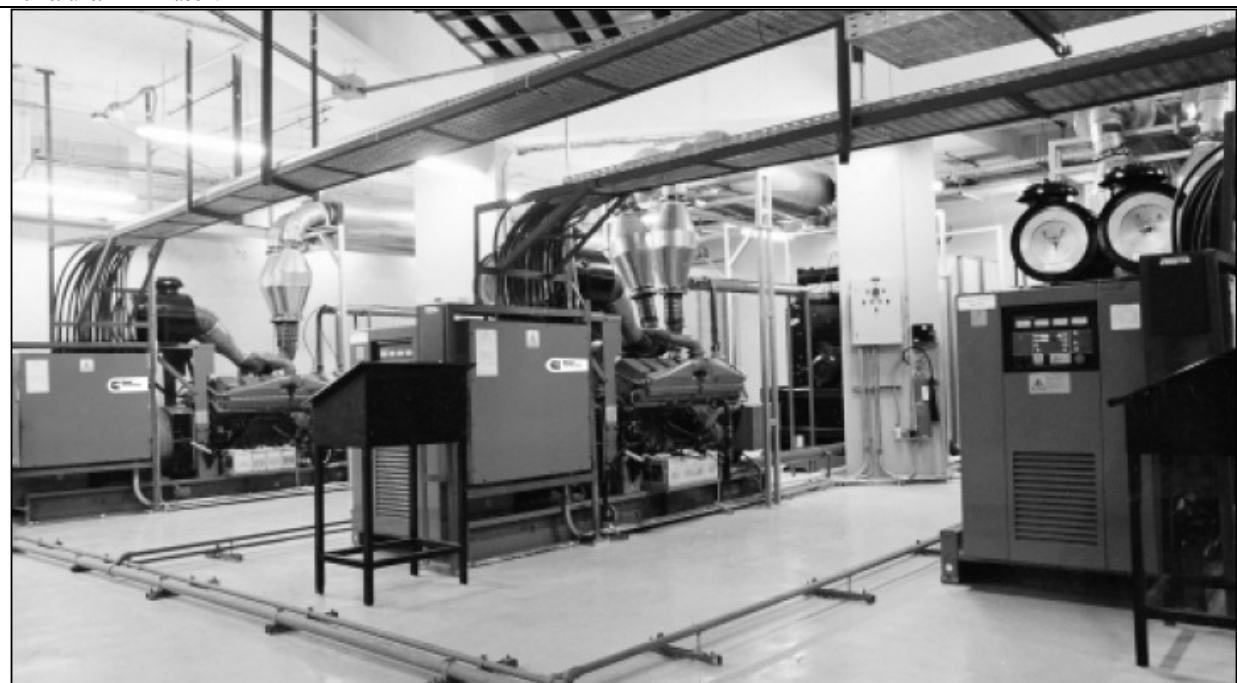
Три дежурных агрегата по 1 МВт каждый с приводом от двигателей Cummins KTA38G4, установленные в больнице и оснащенные каталитическими конвертерами с целью уменьшения выхлопных выбросов.
