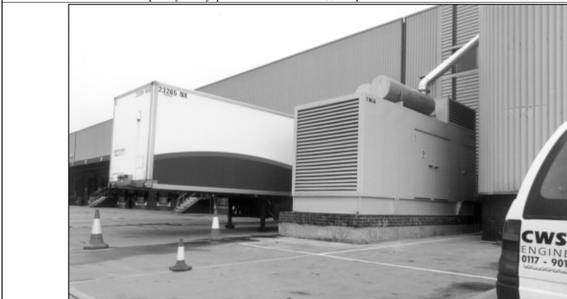
Сверхмалошумный (75 дБ(А) на 1 м) автоматический дежурный агрегат на 1000 кВА на складе крупной сети гипермаркетов.
