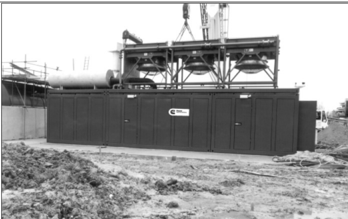
Полная установка газового генераторного агрегата на 1750 кВт агрегата с радиаторами выхлопной системой на крыше.
