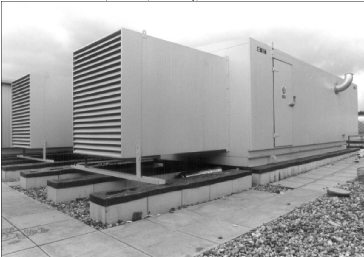
Два агрегата по 1000 кВА, установленные на крыше универсама с максимальным шумоподавлением и расширенными аттенюаторами.
