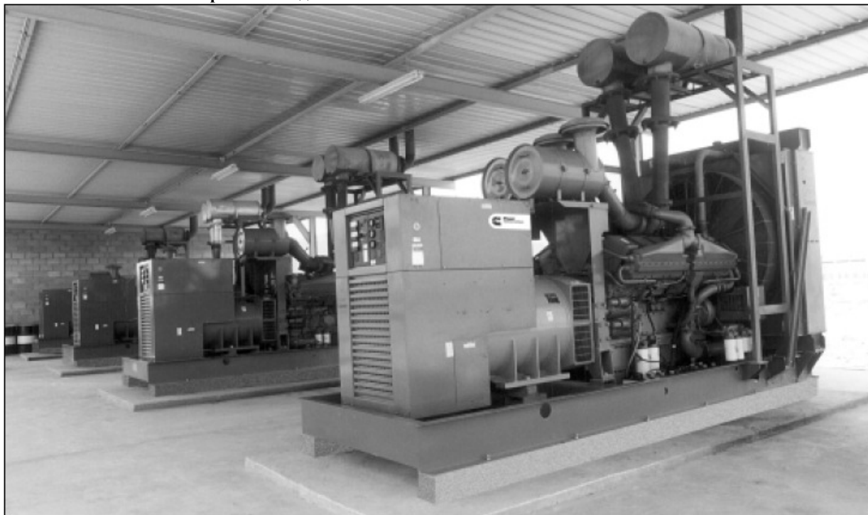
Установка 4-х агрегатов по 800 кВА каждый в машинном зале на уровне земли с простой, но эффективной выхлопной системой
