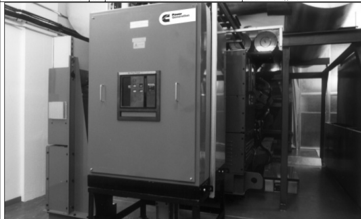
Отдельно установленный моторизованный прерыватель
