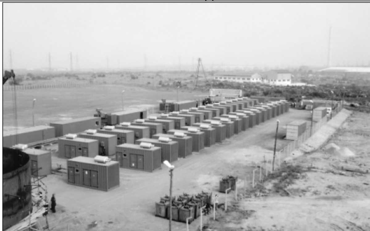
Тридцать девять агрегатов по 1125 кВА с двигателями KTA50 работают параллельно с использованием систем управления PCC и DMC, вырабатывая в совокупности 30 МВт энергии.
