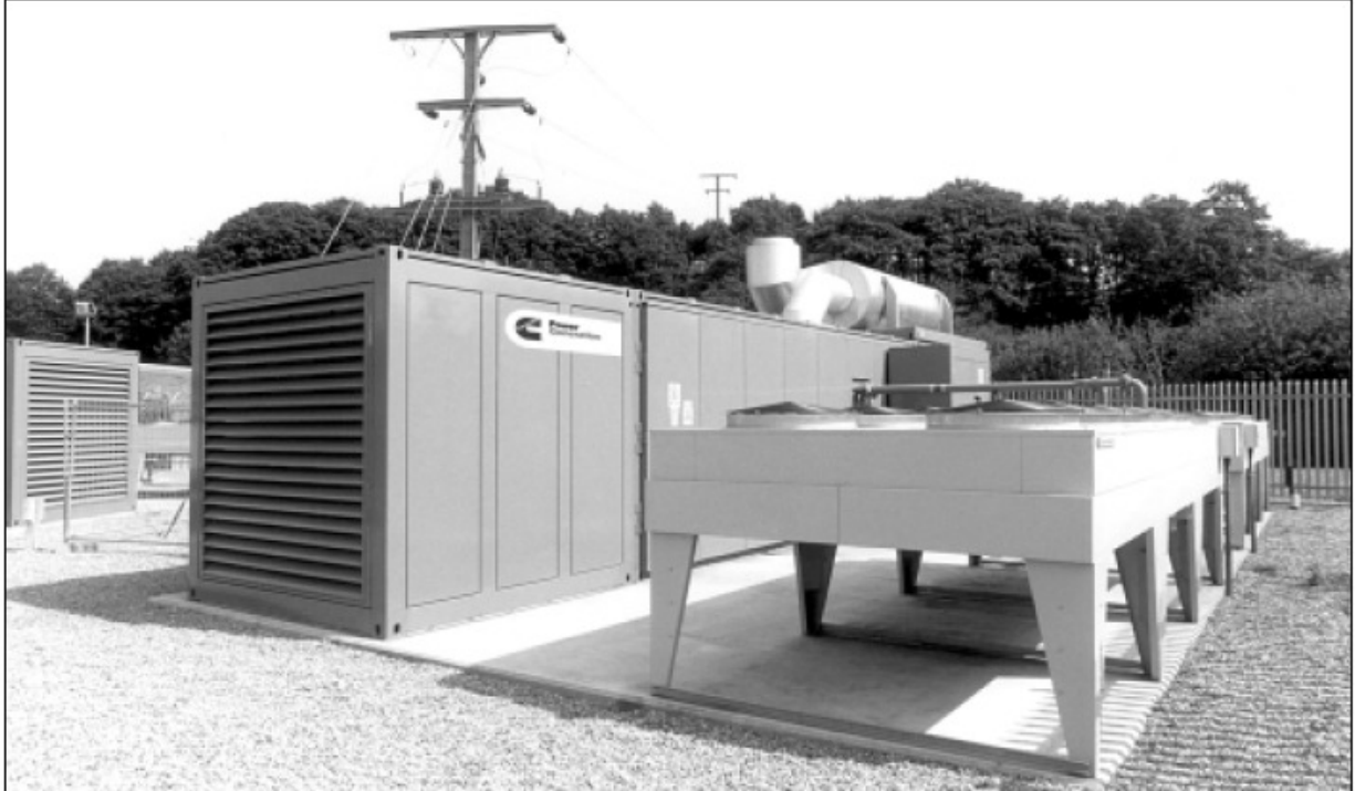
Рис. F7. Пример малошумного корпуса контейнерного типа для генераторов до 2000 кВА.
