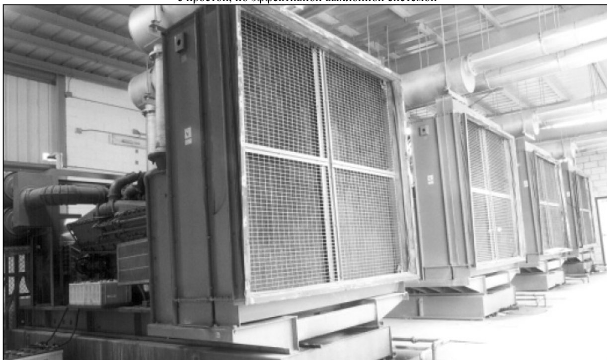
Четыре агрегата по 150 кВА с двигателями KTA50 работают с базисной нагрузкой в Саудовской Аравии
