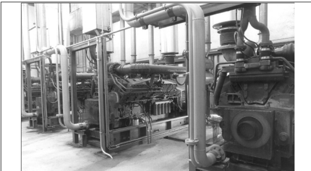
Четыре непрерывно работающих агрегата с двигателями KTA50 и теплообменным охлаждением на фабрике в Испании
