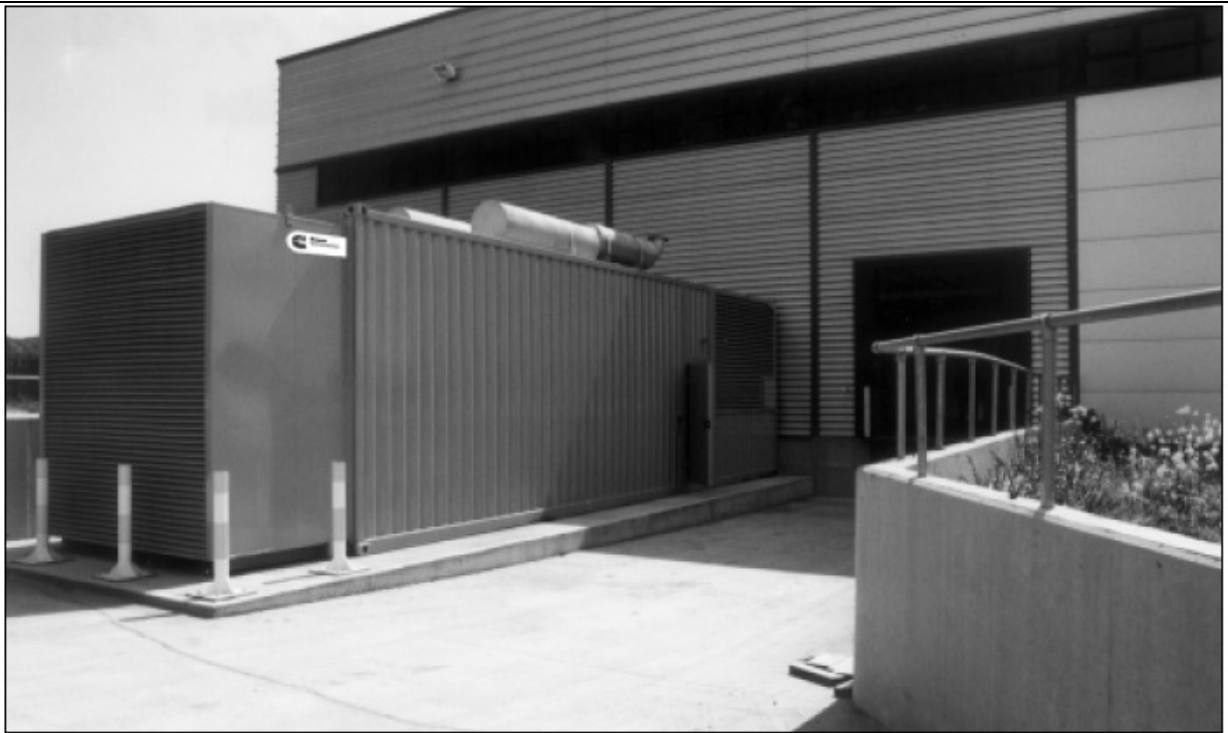
Малошумные контейнерный корпус длиной 12 м (40 футов) с генератором на 2000 кВА. Низкий уровень шума допускает установку поблизости от здания, уменьшая длину кабеля.
