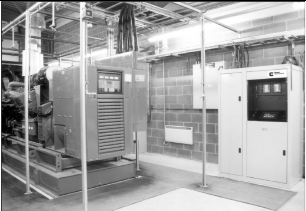
Подводка кабелей к модулю панели управления со шкафом цифрового главного контроллера (DMC) и настенная коробка контакторного переключателя рядом с генераторным агрегатом.
