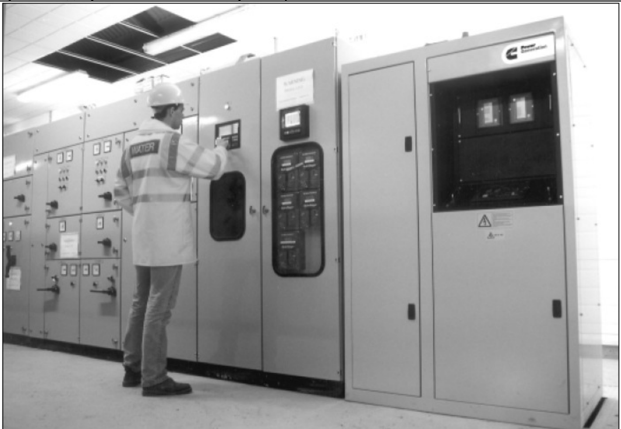
Шкаф цифрового главного контроллера (DMC), установленный рядом с распределительной аппаратурой водяных компаний. Доступ осуществляется спереди.
